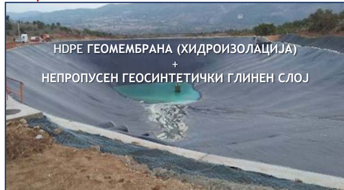
Непропусна хидро-изолација / заштитна подлога за собирни хидротехнички објекти за раствори и одлагалиште за лужење
